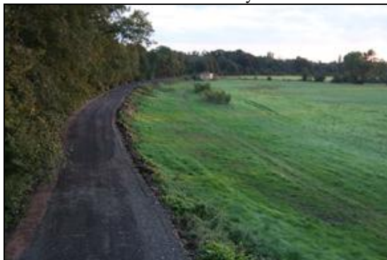
Obr. 21. Chlumec nad Cidlinou, polovina aleje u Cidliny byla zničena kvůli rozšíření komunikace
