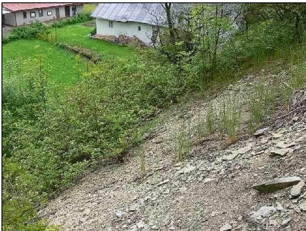
Obr. 2. Obnažená část lokality.
